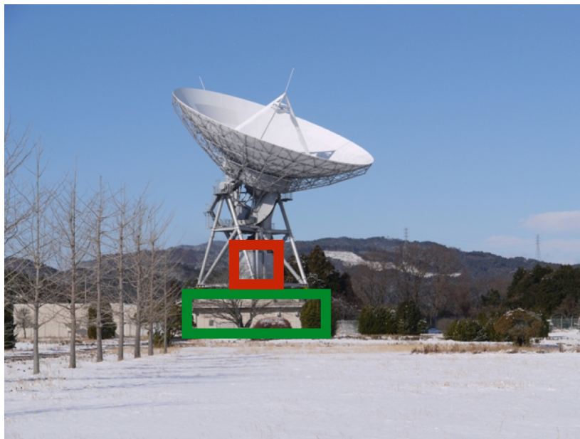
図 2 茨城 32m 電波望遠鏡の日立局。赤枠が巻取室、緑枠が観測室をそれぞれ表す。
